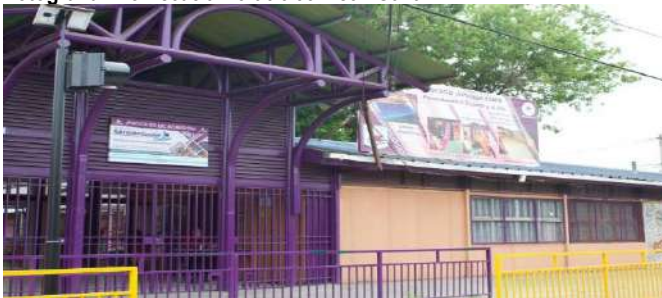
Fotografía N°8: Escuela Horacio Johnson Gana
