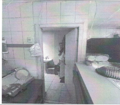
Acceso a baño de local B
