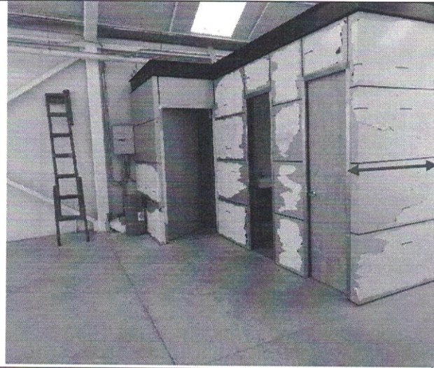
Muro en área de baño de mujeres en Eje 2 es de 1.14m. No corresponde a lo aprobado en P.E. N°16/2020, ni a Planimetría acogida a ART 5.2.8. OGUC
