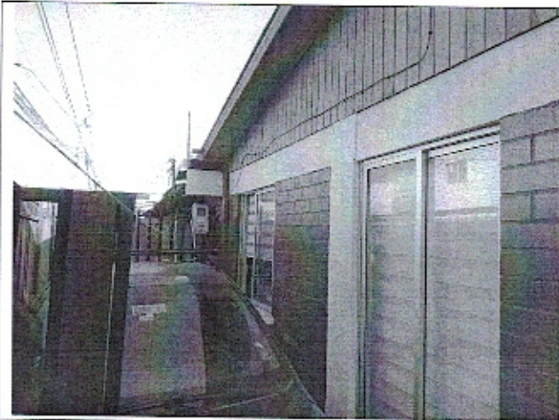
VISTA EXTERIOR FACHADA
