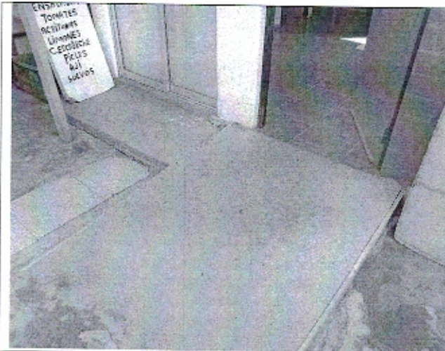
VISTA RAMPA DE ACCESO SIN DESCANSO
